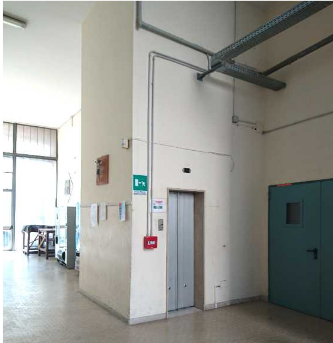
vano ascensore zona bidelleria vicolo S.Nevolone
